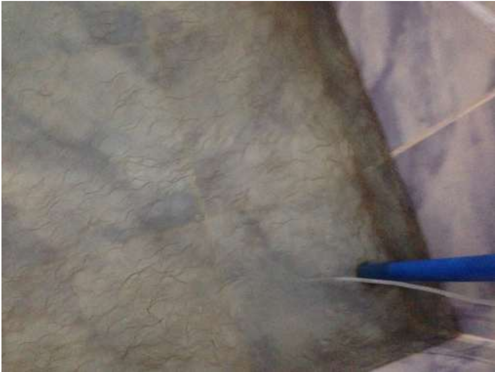
シラス池 (TANK) いれの様子
